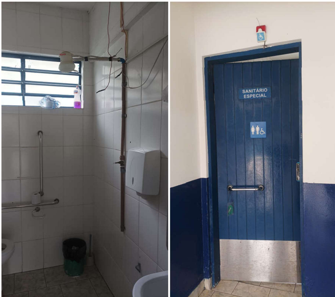
FOTO 17 – CHUVEIRO E PORTAS EM DESCONFORMIDADE
