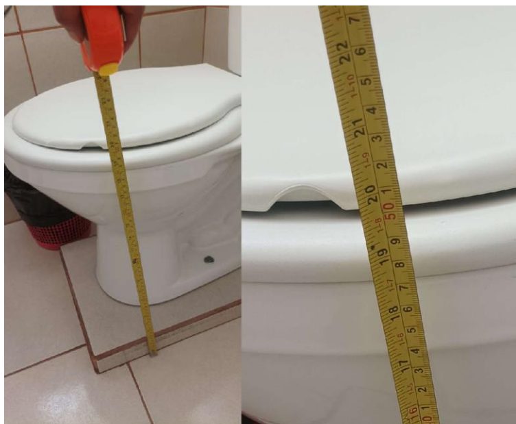
FOTO 19 – SANITÁRIO ACESSÍVEL – VISTA DA BACIA COM ALTURA ACIMA DA PERMITIDA
