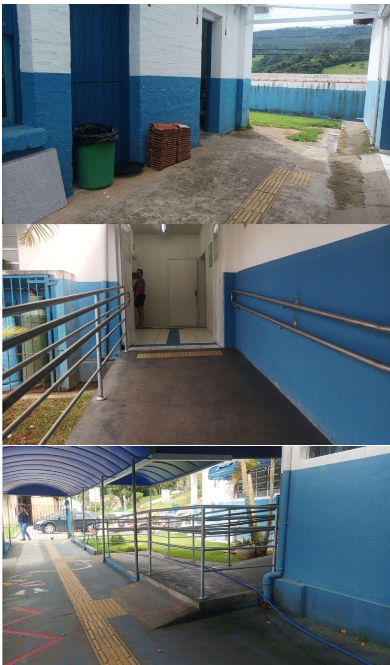
FOTO 9,10,11 E 12 – PISO TÁTIL DIRECIONAL E PISO TÁTIL DE ALERTA EM ROTA ACESSÍVEL NA ÁREA EXTERNA EM DESCONFORMIDADE E RAMPA OBSTRUINDO PARTE DA ROTA ACESSÍVEL
