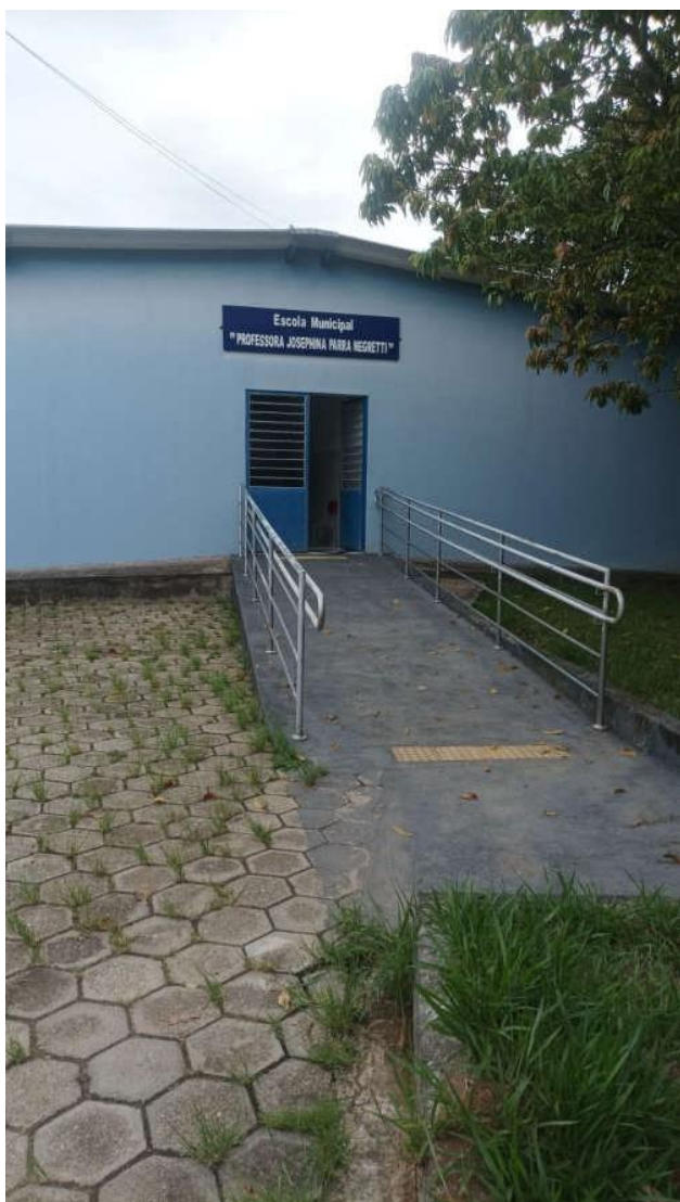
FOTOS 8 E 9 – RAMPA COM PISO TÁTIL DE ALERTA EM DESCONFORMIDADE (Fonte: Tobias Soares Bádue).
