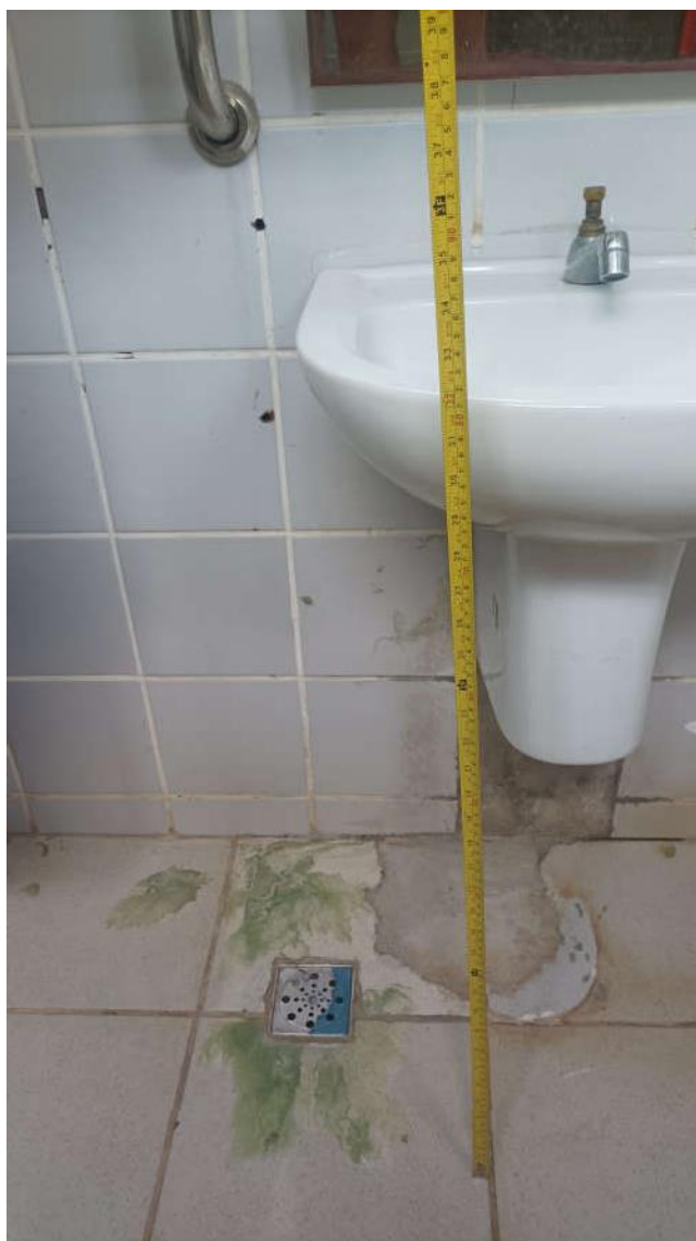
FOTOS 31 E 32 – BOXE SANITÁRIO DO BANHEIRO MASCULINO – ALTURA DO LAVATÓRIO EM DESCONFORMIDADE (Fonte: Tobias Soares Bádue).
