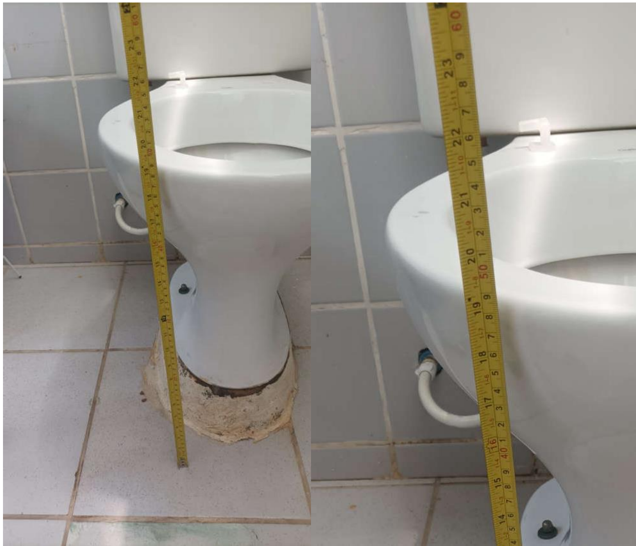
FOTOS 21 E 22 – ALTURA DA BACIA DESCONFORME NO BOXE SANITÁRIO ACESÍVEL FEMININO (Fonte: Tobias Soares Bádue).
