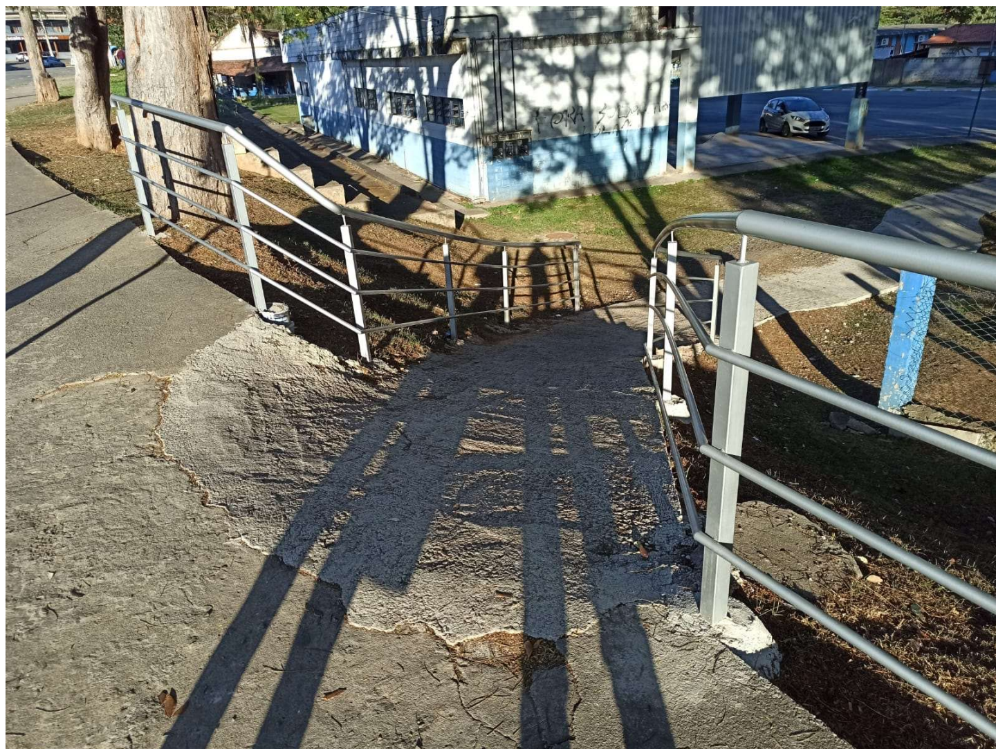
FOTO 5 – RAMPA DESCONFORME NO ACESSO A EDIFICAÇÃO (Fonte: Tobias Soares Bádue).
