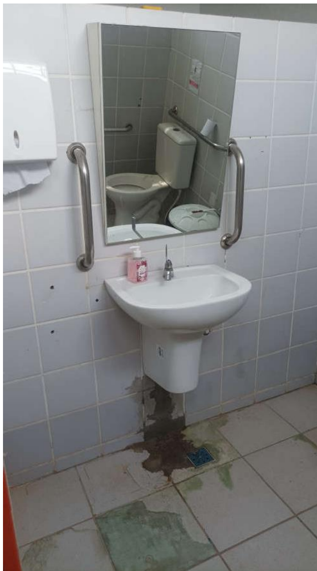
FOTOS 25 E 26 – BOXE SANITÁRIO DO BANHEIRO FEMININO - BARRAS DA BACIA SANITÁRIA EM CONFORMIDADE, PORÉM OBSERVAMOS A FALTA DE PAPELEIRA, E O ACIONAMENTO DA DESCARGA EM CAIXA ACOPLADA É DESCONFORME. AS BARRAS DO LAVATÓRIO ESTÃO EM DESCONFORMIDADE, BEM COMO, A ALTURA DA PAPELEIRA E OBSERVAMOS A FALTA DE SABONETEIRA E OUTROS (Fonte: Tobias Soares Bádue).
