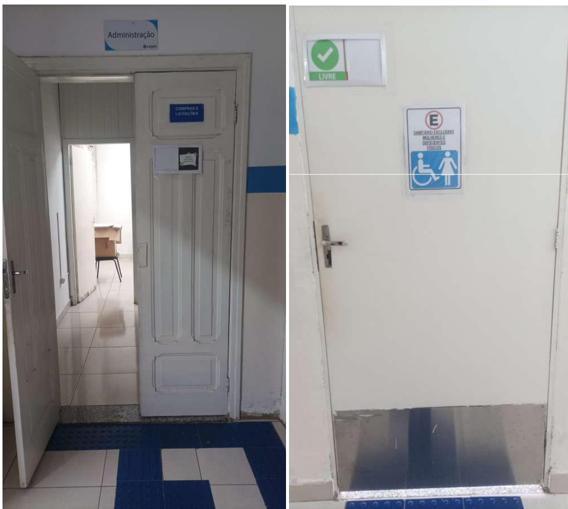
FOTO 16 E 17 – PISO TÁTIL DIRECIONAVEL E PISO TÁTIL DE ALERTA EM DESCONFORMIDADE
