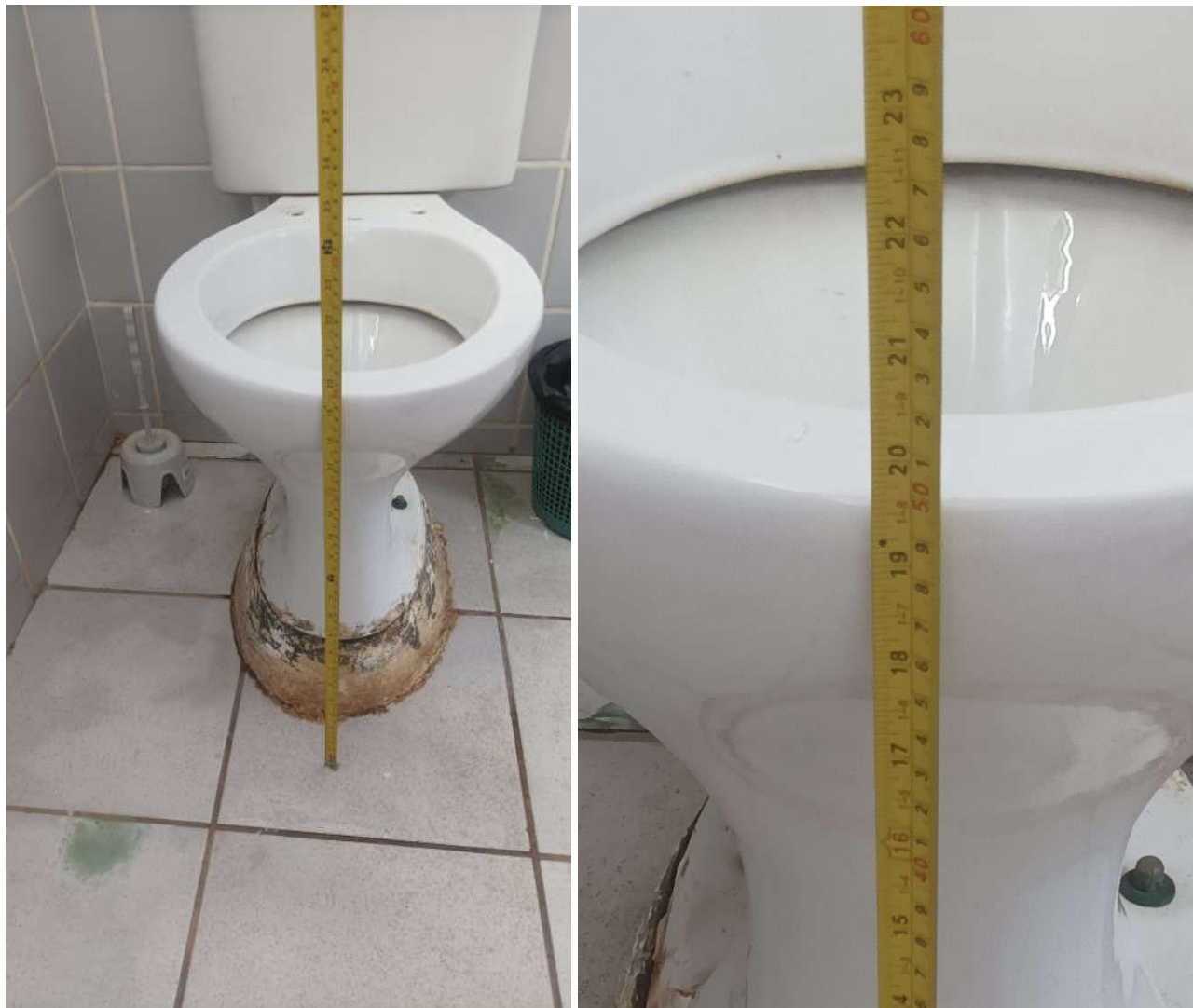
FOTOS 23 E 24 – ALTURA DA BACIA DESCONFORME NO BOXE SANITÁRIO ACESÍVEL MASCULINO (Fonte: Tobias Soares Bádue).
