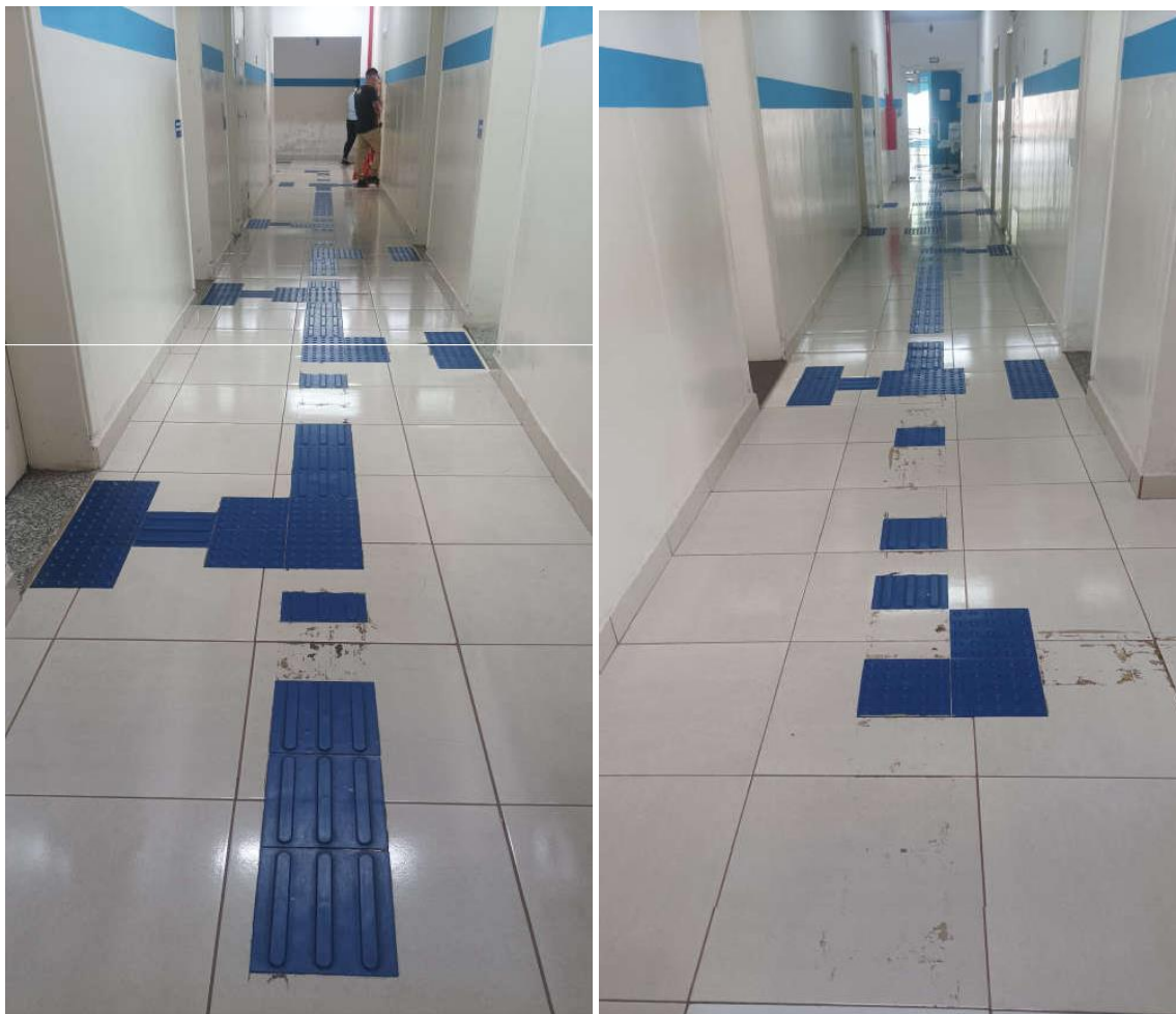
FOTO 15 E 16 – PISO TÁTIL DIRECIONAVEL E PISO TATIL DE ALERTA EM DESCONFORMIDADE
