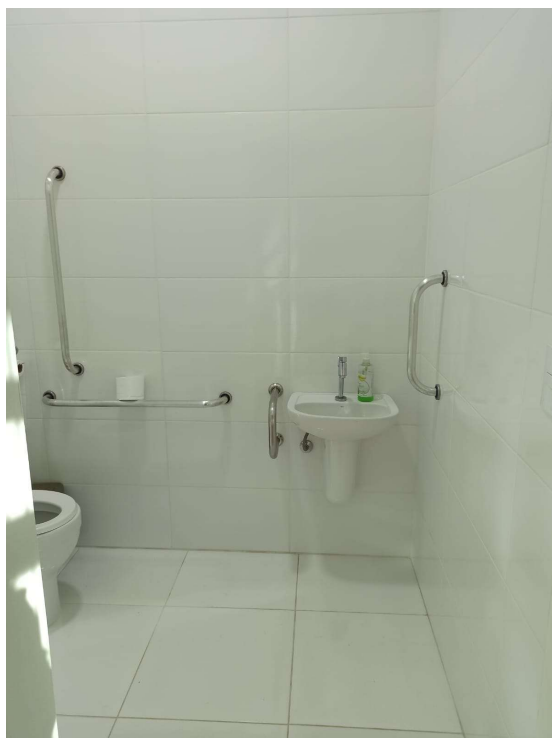
FOTO 9 – BACIA COM ACIONAMENTO DA DESCARGA EM DESCONFORMIDADE. BEM COMO, BARRA PERPENDICULAR ATRÁS DA BACIA, E PAPELEIRA, EM DESCONFORMIDADE. SEM ALARME DE EMERGÊNCIA. (Fonte: Ingrid da Silva Pereira).
