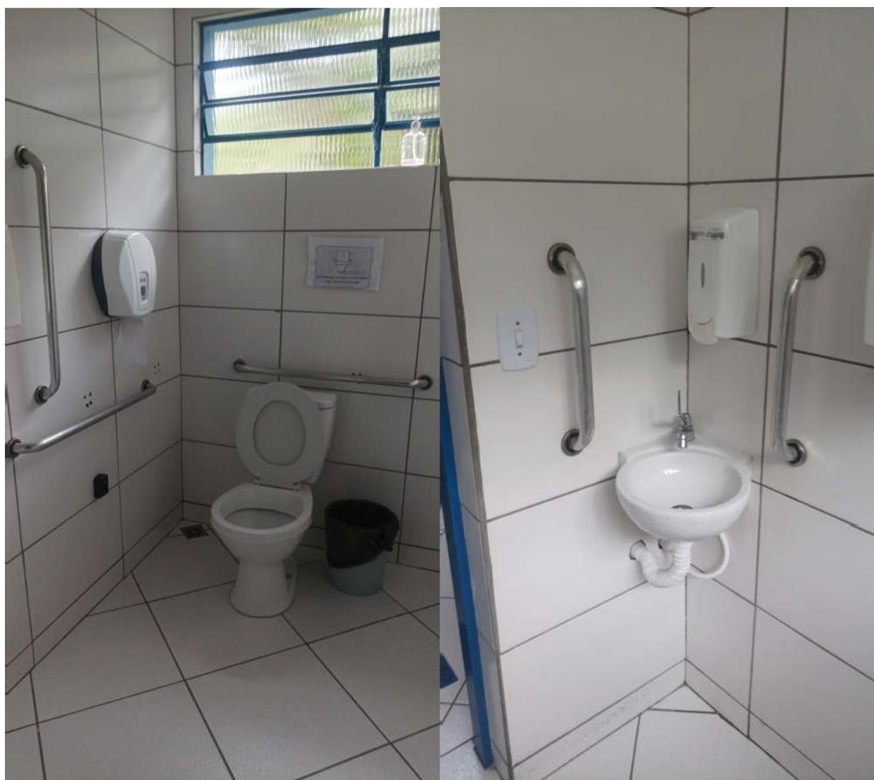
FOTOS 13 E 14 – INTERNA PADRÃO DOS BANHEIROS BACIA E LAVATÓRIO COM AS DEVIDAS BARRAS, PAPELEIRAS, SABONETEIRA E TOALHEIRO (Fonte: Tobias Soares Bádue).
