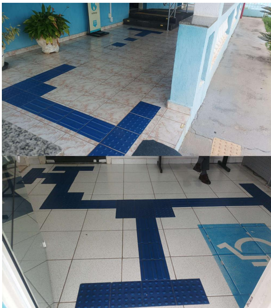
FOTO 13 E 14 – PISO TÁTIL DIRECIONAVEL E PISO TÁTIL DE ALERTA EM DESCONFORMIDADE
