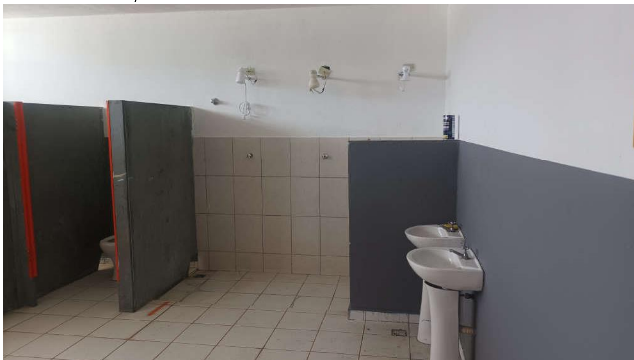
FOTO 34 – VESTIÁRIO (SITUAÇÃO EM AMBOS) – CHUVEIRO NÃO POSSUI BARRASE ASSENTO, NÃO POSSUI LAVATÓRIO SEM COLUNA, COM ALTURA CONFORME E BARRAS (Fonte: Tobias Soares Bádue).
