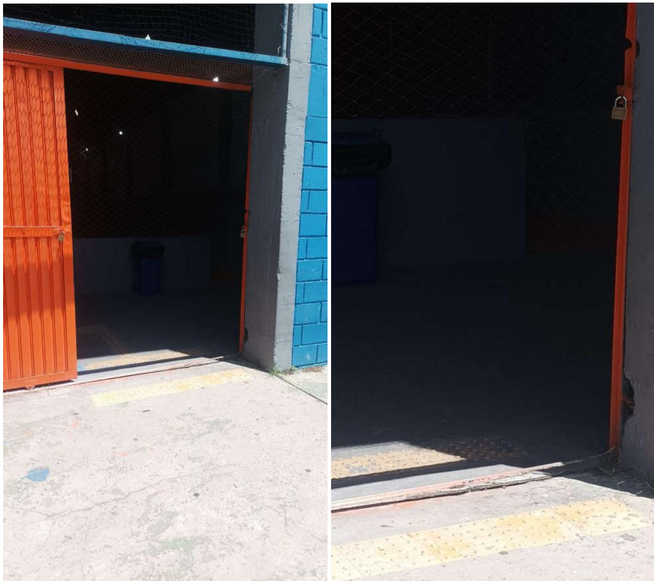
FOTOS 7 E 8 – TRILHO DO PORTÃO CRIANDO DESNÍVEL NO PISO E DETERIORADO (Fonte: Tobias Soares Bádue).
