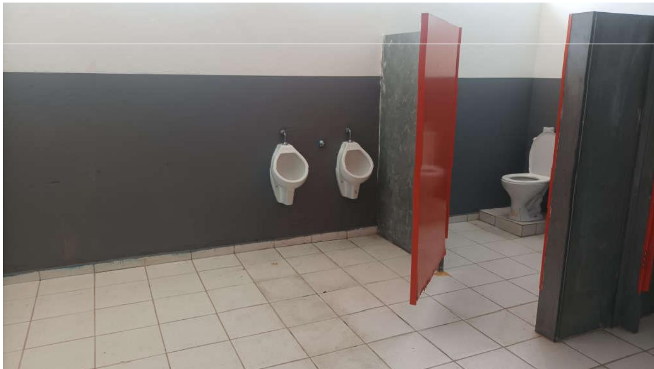
FOTO 35 – VESTIÁRIO (SITUAÇÃO EM AMBOS) – BOXE SANITÁRIO PNE SEM LAVATÓRIO, BACIA EM ALTURA DESCONFORME, INEXISTÊNCIA DE BARRAS E PAPELEIRA NA BACIA, INEXISTÊNCIA DE LAVATÓRIO NO BOXE ACESSÍVEL. NÃO EXISTE MICTÓRIO ACESSÍVEL (Fonte: Tobias Soares Bádue).
