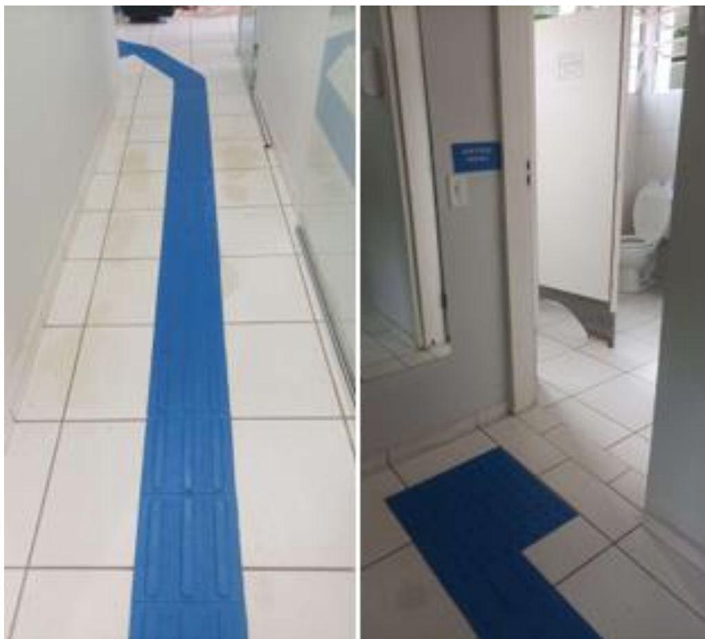
FOTO 3 – PISO TÁTIL DIRECIONAL E PISO TÁTIL DE ALERTA EM TRANSPOSIÇÃO DE PORTAS INSTALADOS EM DESCONFORMIDADE
