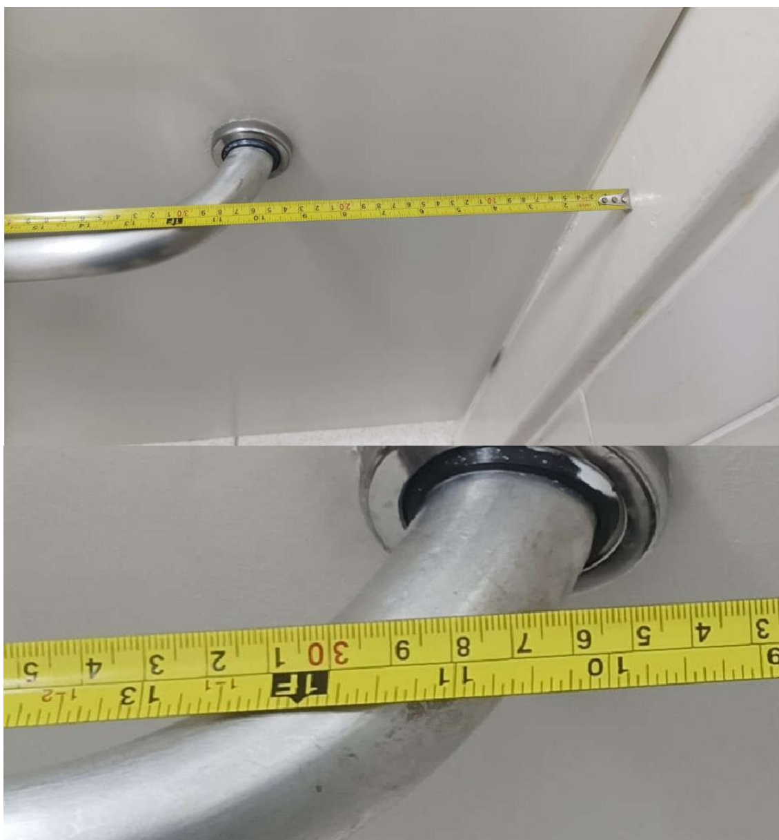
FOTO 6 – PUXADORES EM DESCONFORMIDADE
