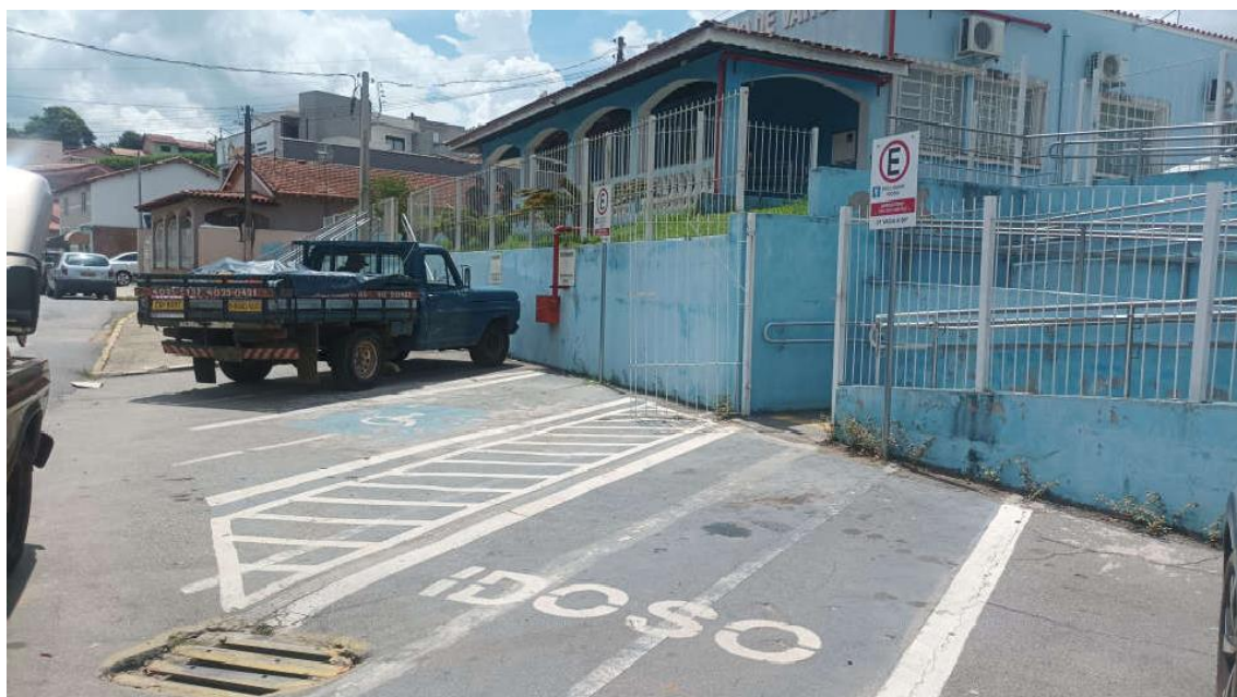
FOTO 6 – DEMARCAÇÃO HORIZONTAL DAS VAGAS ESPECIAIS CONFLITANTES NO ESTACIONAMENTO PARA USO PÚBLICO
