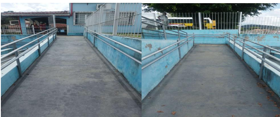
FOTO 11 – DETALHE DA RAMPA DE ACESSO PARA ÁREA EXTERNA
