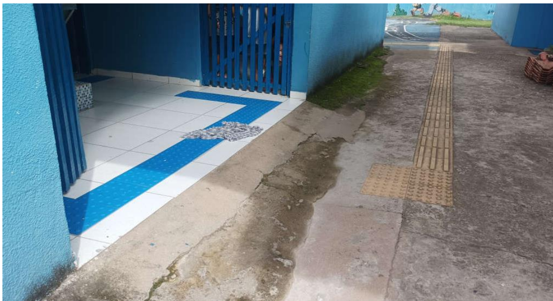
FOTO 14 – DESNÍVEL E SINALIZAÇÃO TÁTIL EM DESCONFORMIDADE
