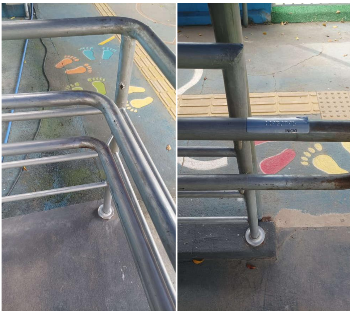
FOTO 5 E 6 – GUARDA CORPO DETERIORADO
