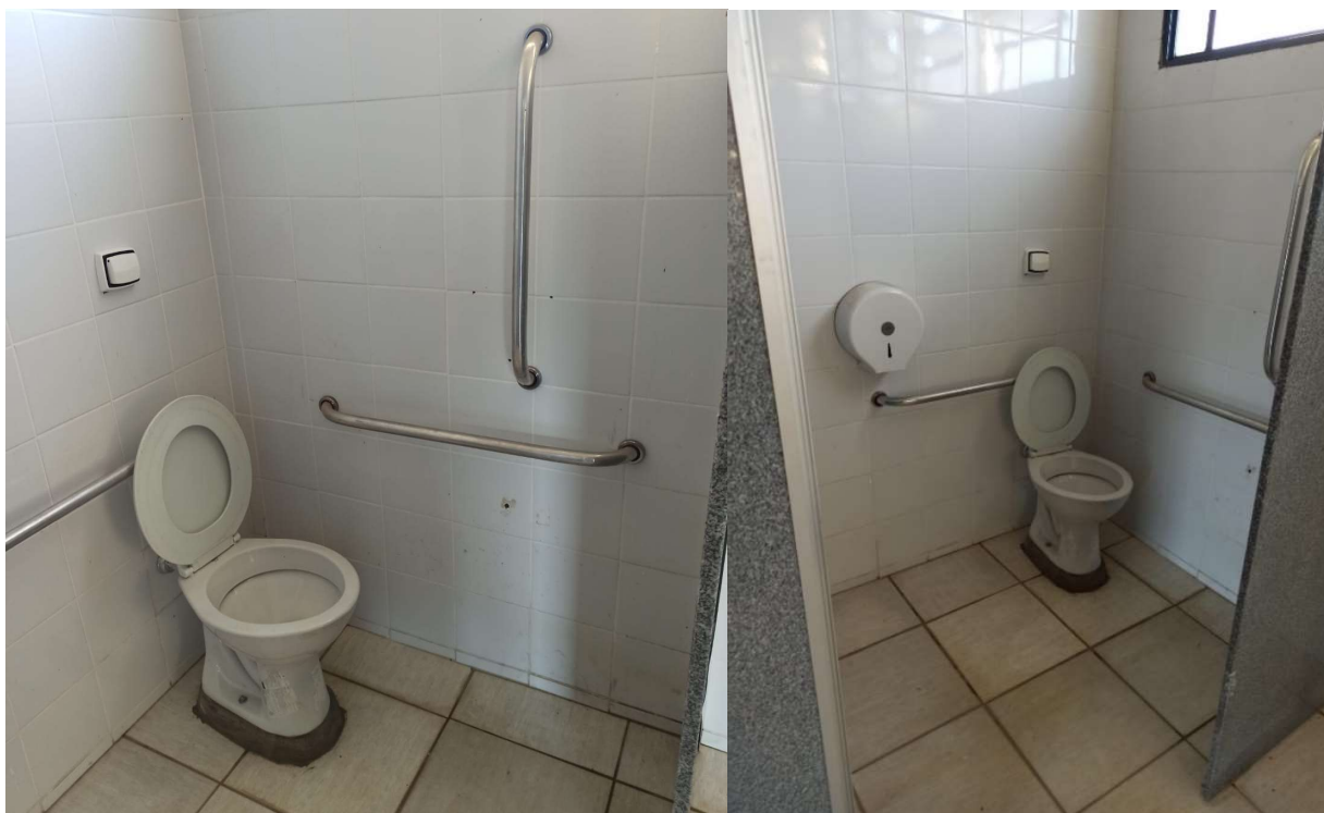
FOTOS 7 E 8 – BACIA COM ACIONAMENTO DA DESCARGA EM DESCONFORMIDADE. BEM COMO, BARRA PERPENDICULAR ATRÁS DA BACIA, E PAPELEIRA, EM DESCONFORMIDADE. SEM ALARME DE EMERGÊNCIA. (Fonte: Ingrid da Silva Pereira).
