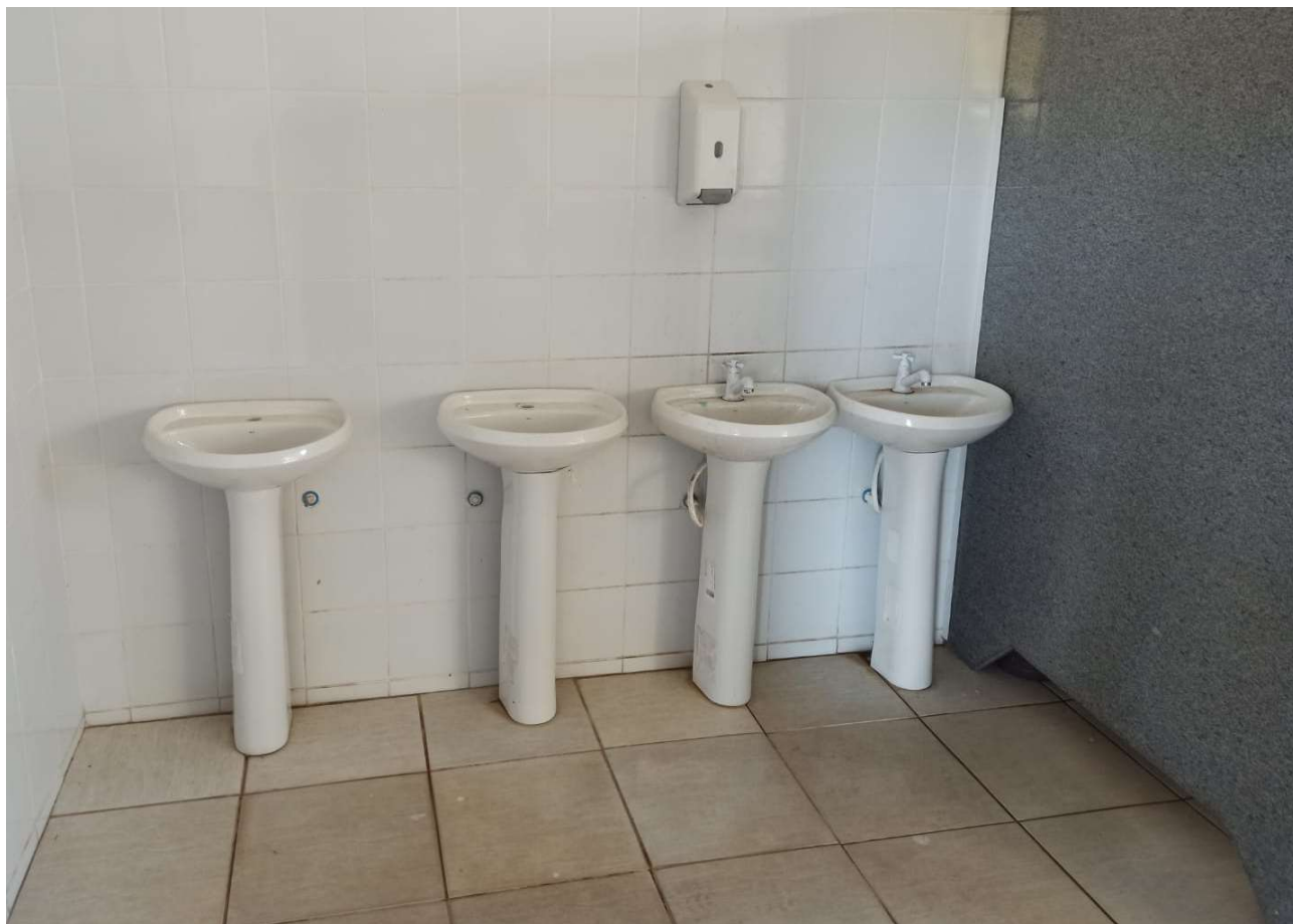
FOTO 9 – LAVATÓRIO EM DESCONFORMIDADE COM A NORMA NBR 9050, ASSIM COMO A FALTA DE SABONETEIRA, TOALHEIRO E OUTROS. (Fonte: Ingrid da Silva Pereira).
