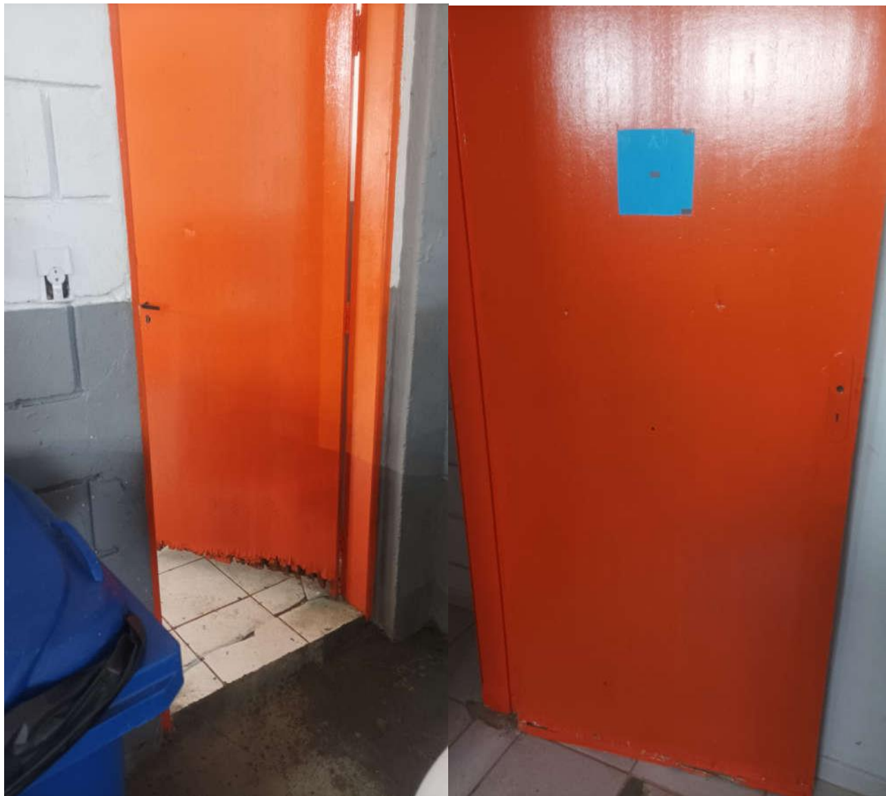
FOTOS 13 E 14 – PORTA DE ACESSO AO VESTIÁRIO SEM SINALIZAÇÃO DE PORTAS E PASSAGENS, COM LARGURA INFERIOR A 1,00 m, E COM DESNÍVEL NO ACESSO AO VESTIÁRIO. NA SEQUÊNCIA, PORTA DO BANHEIRO MASCULINO SEM SINALIZAÇÃO (Fonte: Tobias Soares Bádue).
