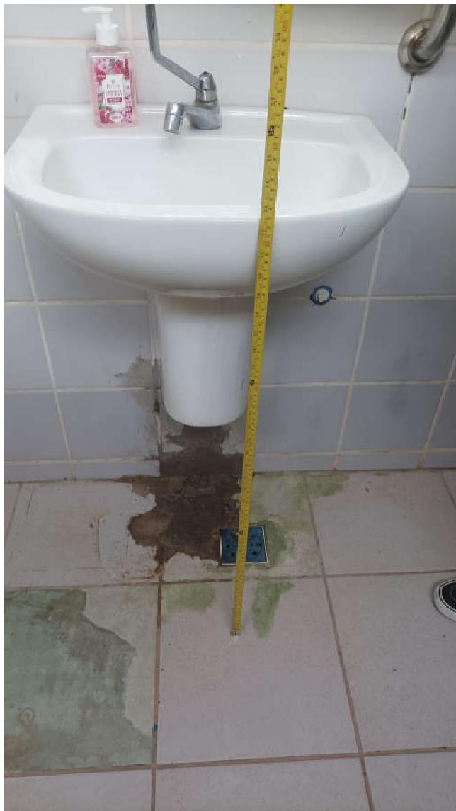
FOTOS 27 E 28 – BOXE SANITÁRIO DO BANHEIRO FEMININO – ALTURA DO LAVATÓRIO EM DESCONFORMIDADE (Fonte: Tobias Soares Bádue).
