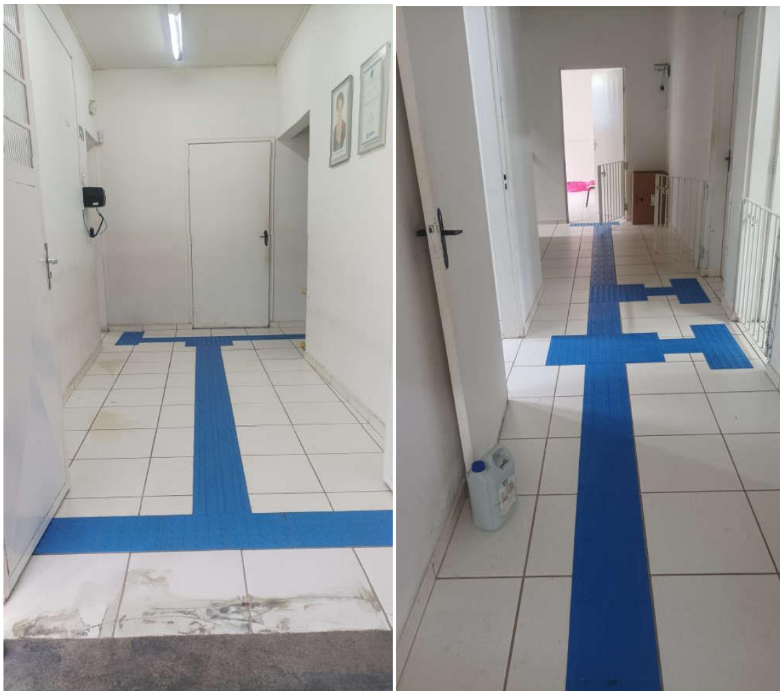
FOTO 7 e 8 – PISO TÁTIL DE ALERTA E PISO TÁTIL DE ALERTA EM DESCONFORMIDADE (FONTE: INGRID DA SILVA PEREIRA)
