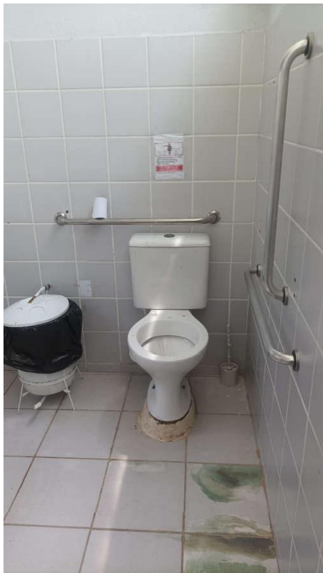
FOTOS 25 E 26 – BOXE SANITÁRIO DO BANHEIRO FEMININO - BARRAS DA BACIA SANITÁRIA EM CONFORMIDADE, PORÉM OBSERVAMOS A FALTA DE PAPELEIRA, E O ACIONAMENTO DA DESCARGA EM CAIXA ACOPLADA É DESCONFORME. AS BARRAS DO LAVATÓRIO ESTÃO EM DESCONFORMIDADE, BEM COMO, A ALTURA DA PAPELEIRA E OBSERVAMOS A FALTA DE SABONETEIRA E OUTROS (Fonte: Tobias Soares Bádue).
