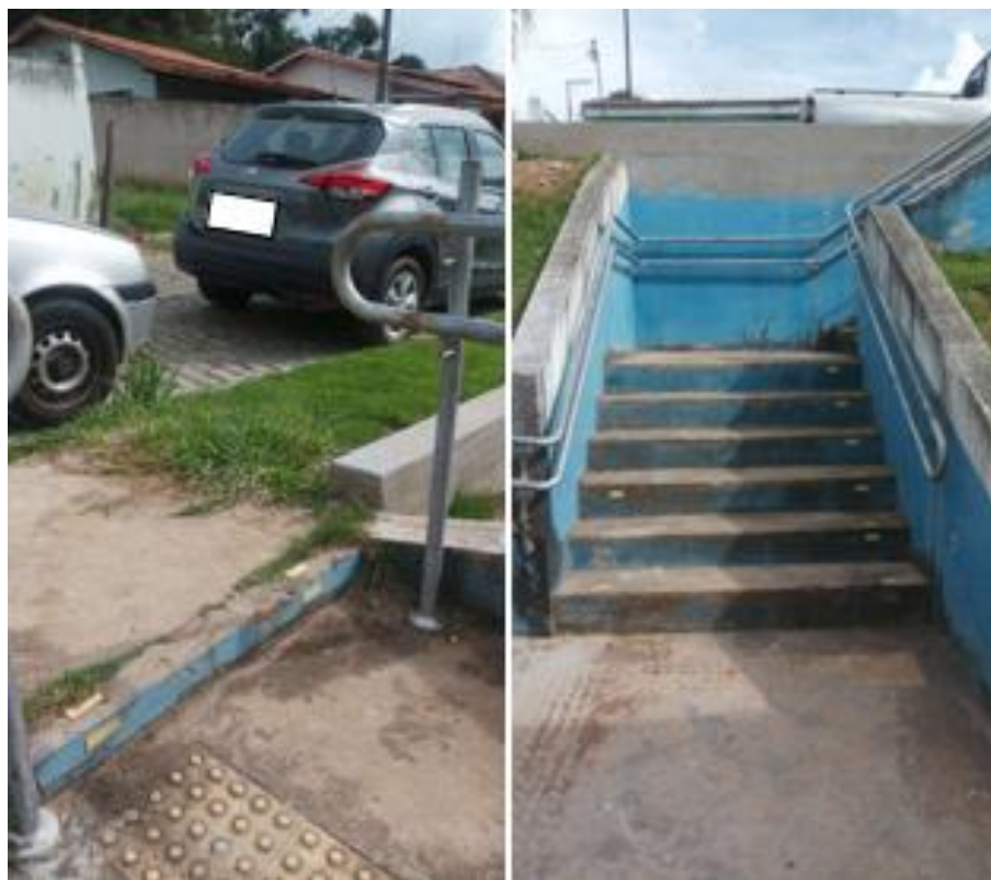
FOTO 4 – PISO TÁTIL DE ALERTA APLICADO NO LOCAL INCORRETO NA E INEXISTÊNCIA DE CONTRASTE COM O PISO EXISTENTE EM AMBAS AS SITUAÇÕES.
