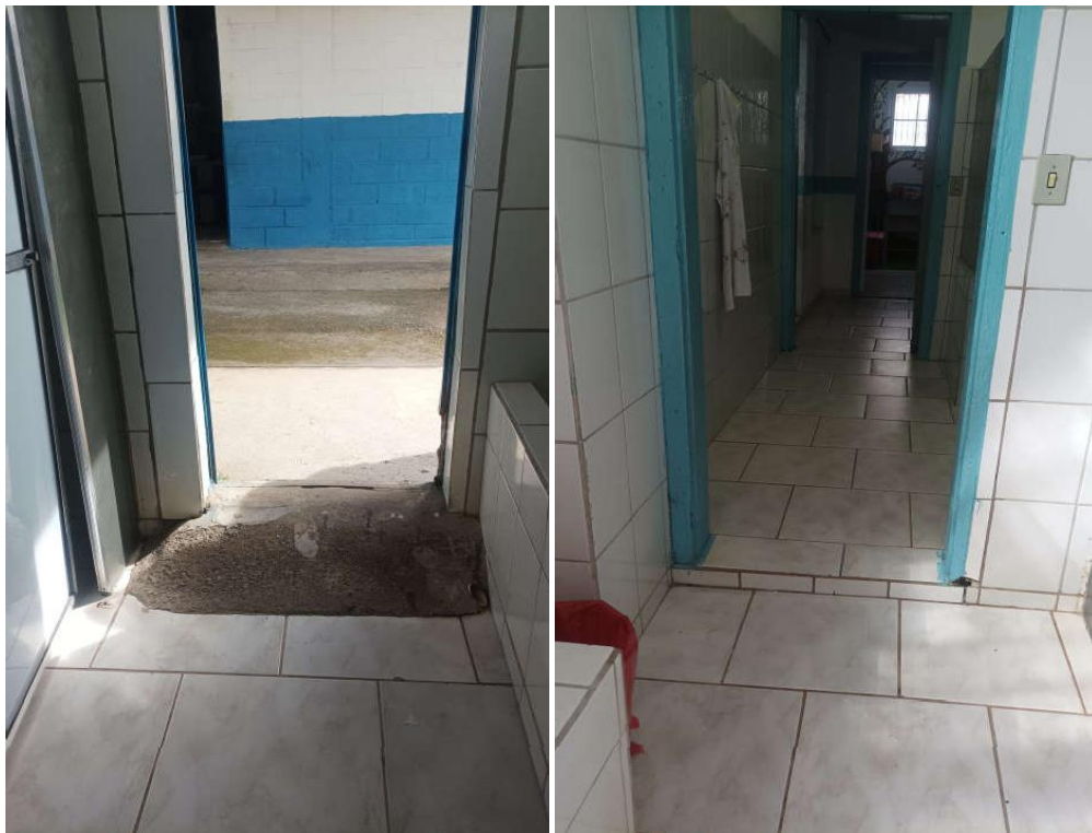
FOTO 15 E 16 – DESNÍVEL EM ACESSO AO BANHEIRO INFANTIL E ÁREA DE CIRCULAÇÃO EM DESCONFORMIDADE – LARGURA DAS PORTAS EM DESCONFORMIDADE
