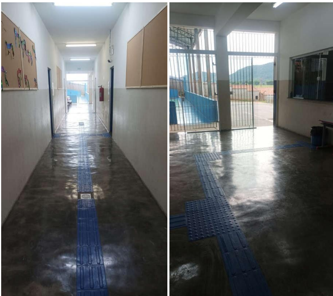
FOTOS 6 E 7 – PISO TÁTIL DIRECIONAL, E PISO TÁTIL DE FALTANDO PEÇAS, RALO OBSTRUINDO A ROTA E INEXISTÊNCIA DE ROTA PARA A QUADRA. (Fonte: Tobias Soares Bádue)
