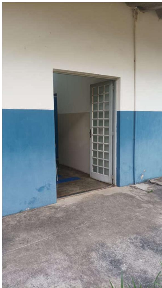
FOTO 10 – DESNÍVEL EM ACESSO A ÁREA EXTERNA EM DESCONFORMIDADE. (Fonte: Tobias Soares Bádue).
