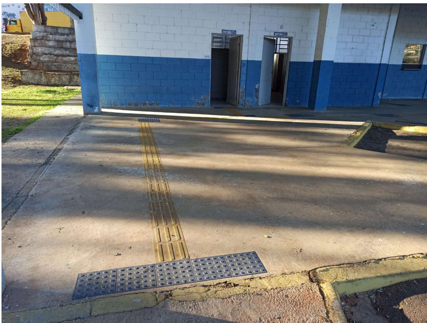
FOTO 6 – PORTA DO BANHEIRO E PISO TÁTIL EM DESCONFORMIDADE. (Fonte: Ingrid da Silva Pereira).
