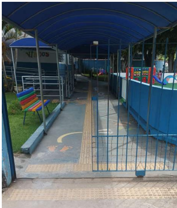
FOTO 3 – ACESSO PRINCIPAL A EDIFICAÇÃO E RAMPA EXTERNA COM INCLINAÇÃO SUPERIOR A 5%
