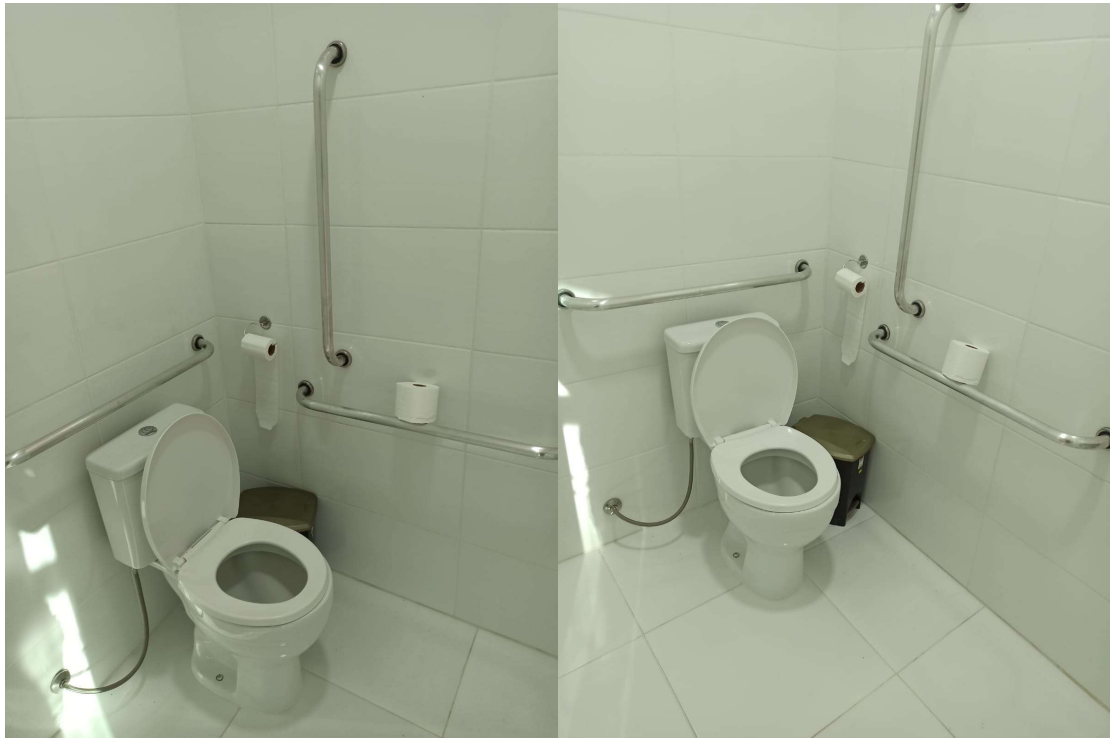
FOTO 9 – BACIA COM ACIONAMENTO DA DESCARGA EM DESCONFORMIDADE. BEM COMO ACESSÓRIOS (BARRA PERPENDICULAR ATRÁS DA BACIA, E PAPELEIRA, EM DESCONFORMIDADE. SEM ALARME DE EMERGÊNCIA. (Fonte: Ingrid da Silva Pereira).
