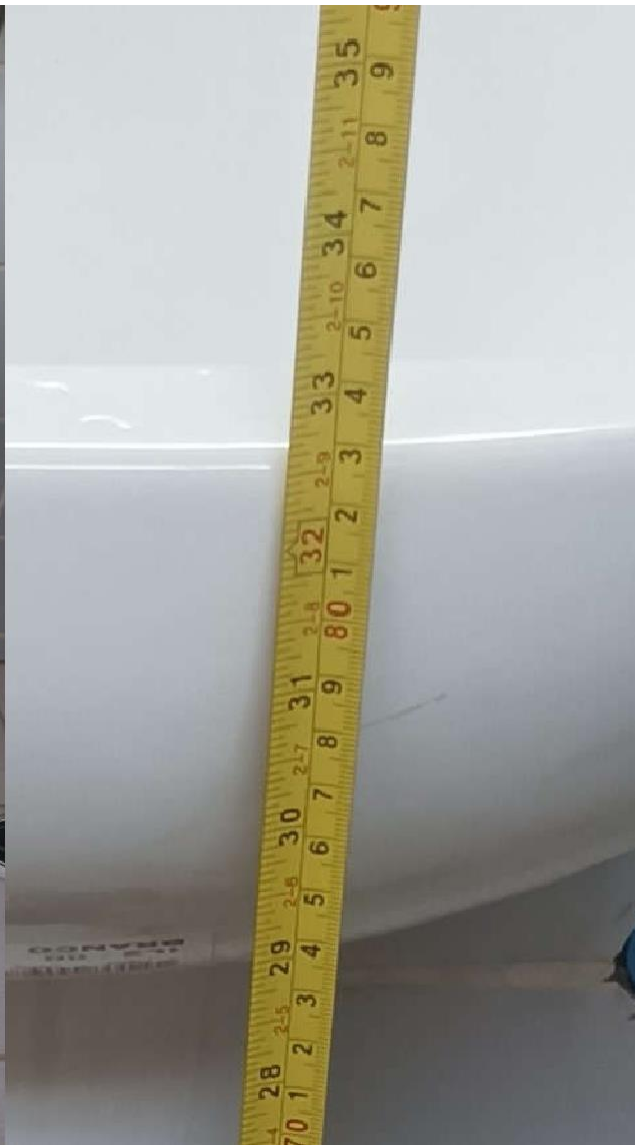
FOTOS 27 E 28 – BOXE SANITÁRIO DO BANHEIRO FEMININO – ALTURA DO LAVATÓRIO EM DESCONFORMIDADE (Fonte: Tobias Soares Bádue).
