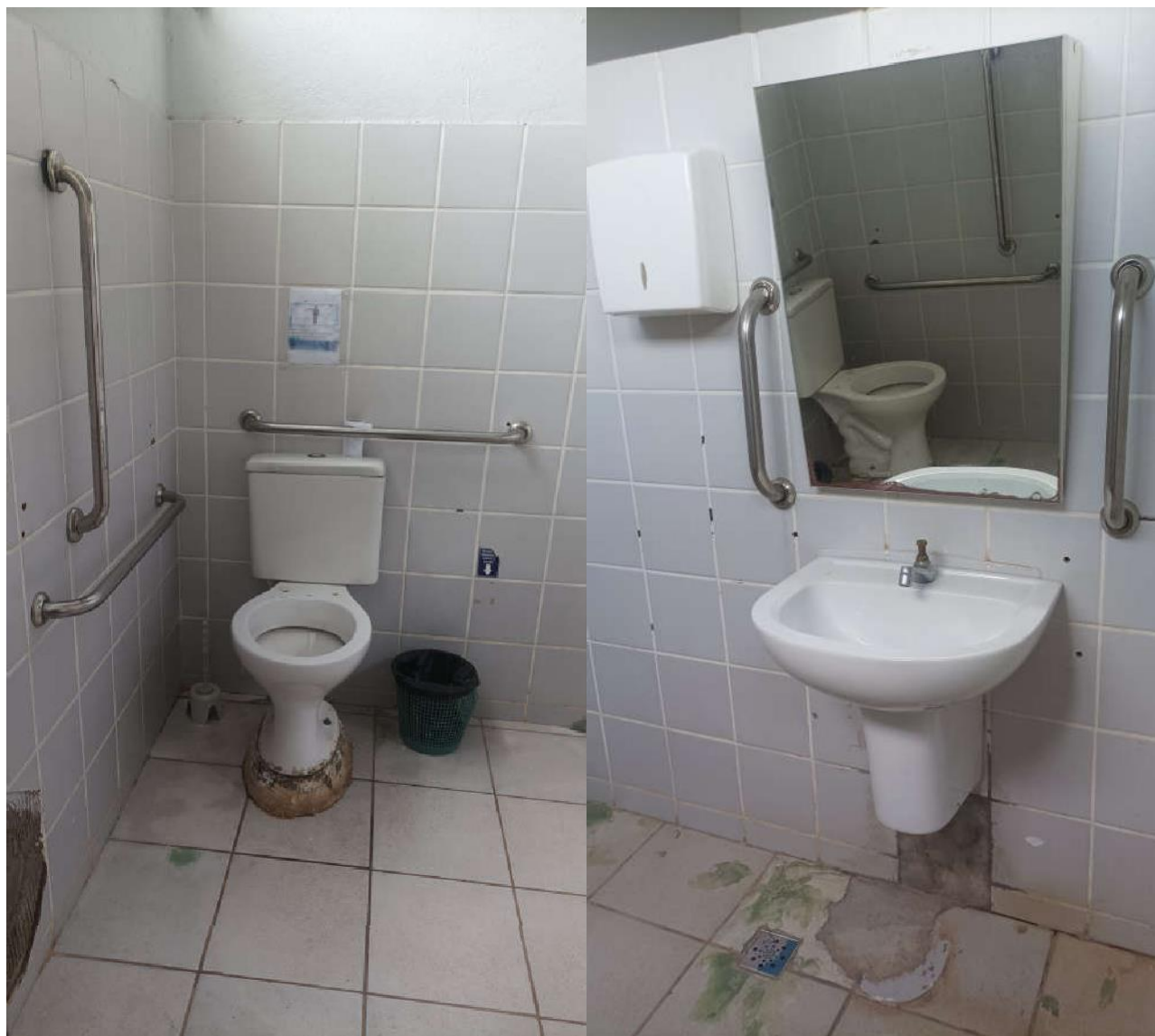
FOTOS 29 E 30 – BOXE SANITÁRIO DO BANHEIRO MASCULINO - BARRAS DA BACIASANITÁRIA EM CONFORMIDADE, PORÉM OBSERVAMOS A FALTA DE PAPELEIRA, E O ACIONAMENTO DA DESCARGA EM CAIXA ACOPLADA É DESCONFORME. AS BARRAS DO LAVATÓRIO ESTÃO EM DESCONFORMIDADE, BEM COMO, A ALTURA DA PAPELEIRA E OBSERVAMOS A FALTA DE SABONETEIRA E OUTROS (Fonte: Tobias Soares Bádue).
