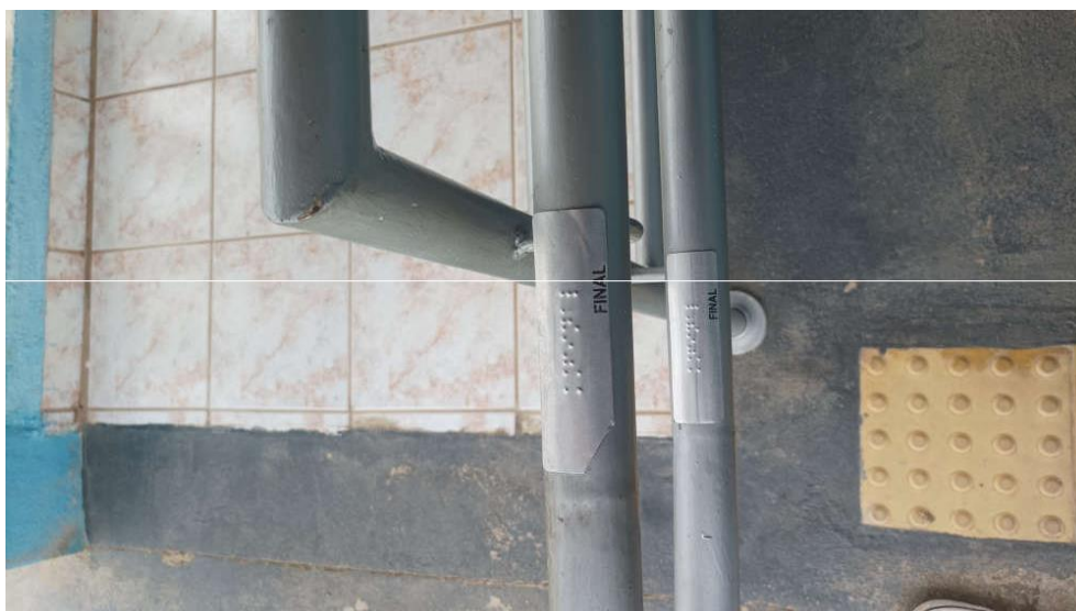
FOTO 12 – DETALHE SINALIZAÇÃO PADRÃO DO CORRIMÃO SEM RELEVO DOS CARACTERES
