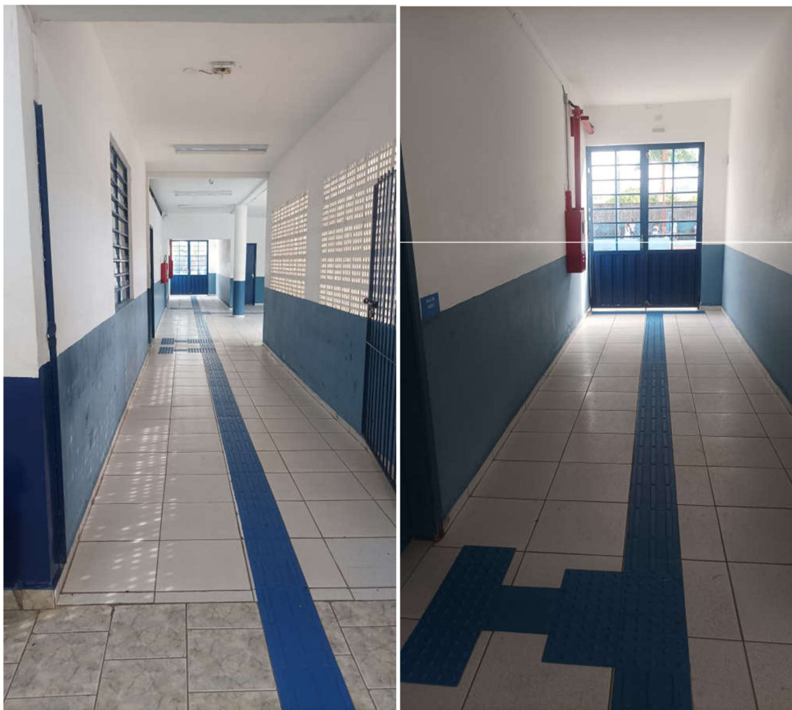
FOTO 9 – CORREDOR COM SINALIZAÇÃO TÁTIL A SER RETIRADA
