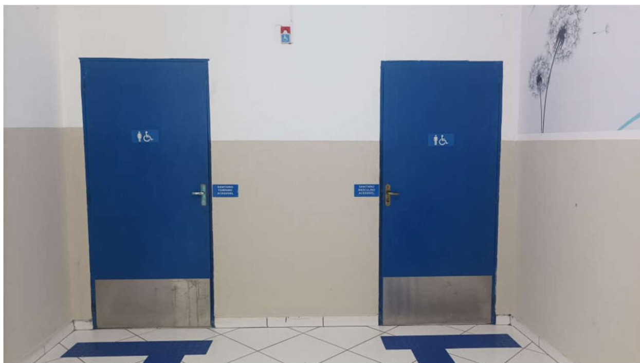
FOTOS 11 E 12 – PORTA DOS BANHEIROS ACESSÍVEIS DE ACESSO INDEPENDENTE. DETALHE VER SINALIZAÇÃO PODOTÁTIL A SER REMOVIDA (Fonte: Tobias Soares Bádue).
